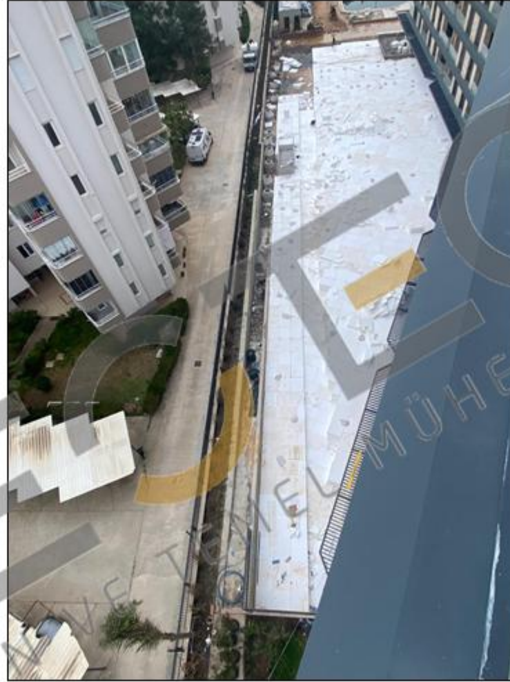
Geofoam blokların yerleşimi ve PVC geomembran ile izolasyon (Siteler tarafı)
