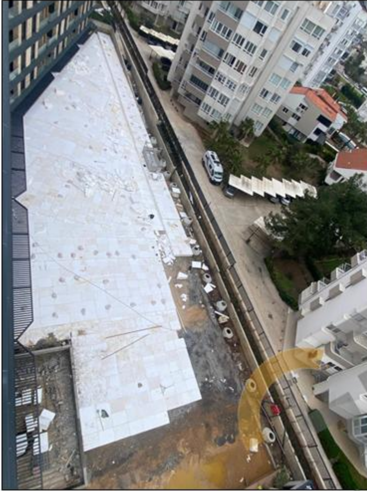
Geofoam blokların yerleşimi ve PVC geomembran ile izolasyon (Siteler tarafı)
