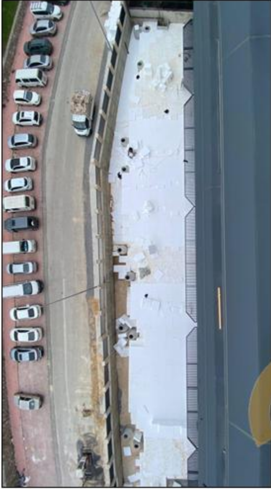
Geofoam blokların yerleşimi ve PVC geomembran ile izolasyon (Düden Çayı tarafı)
