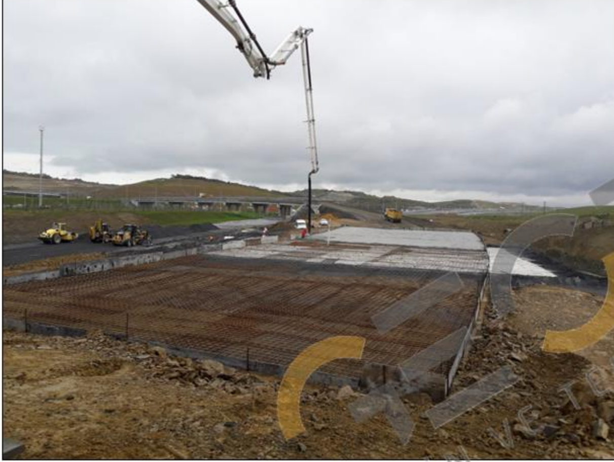
Betonarme yük yayma platformu inşaatı
