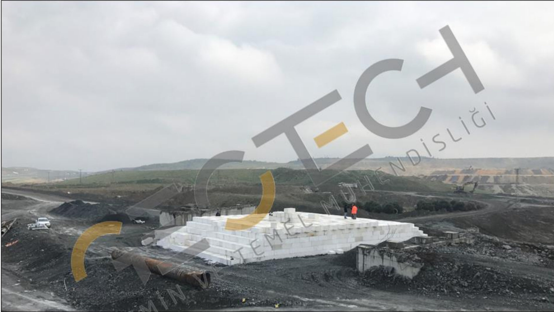
Geofoam blokların yerleşimi
