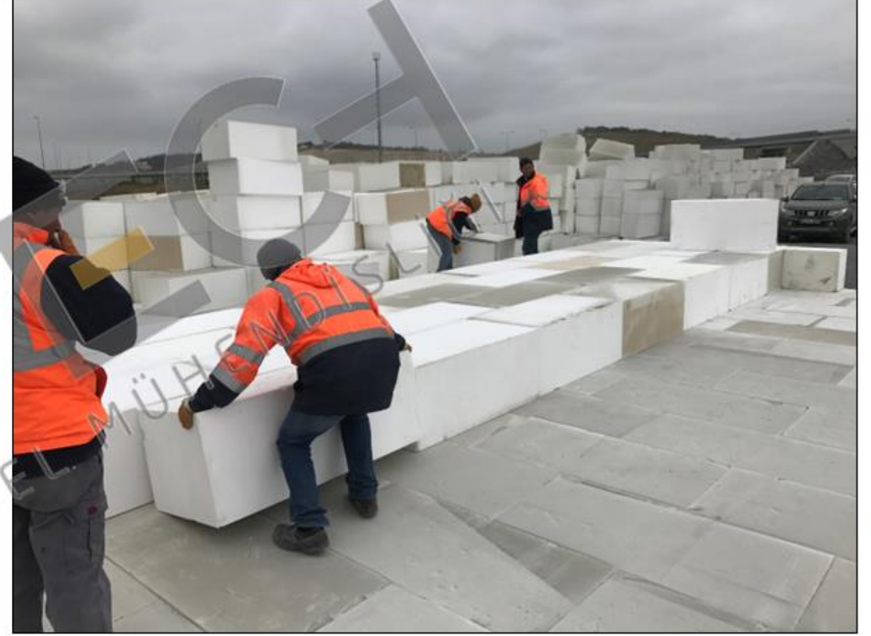
ZEMİN VE TEMEL MÜHÜR Geofoam blokların yerleşimi
