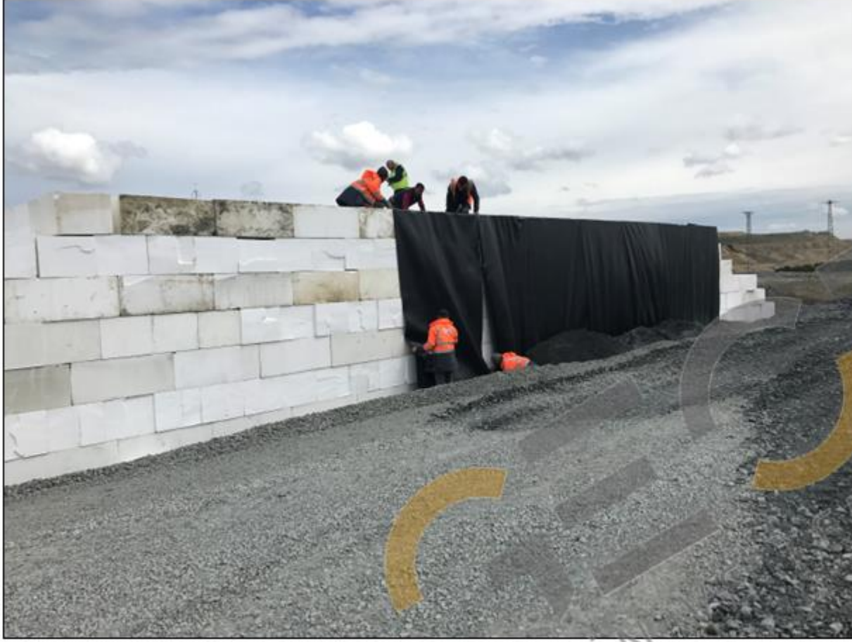
Geofoam blok dolgunun düşey yüzeylerinin PVC geomembran ile kaplanması
