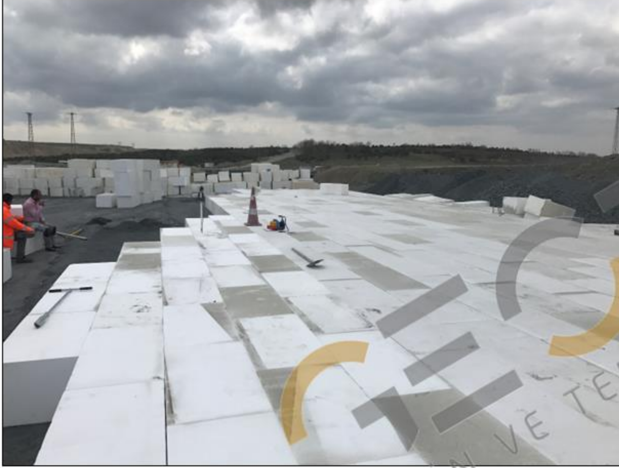
ZEMİN VE TEMEL MÜHÜR Geofoam blokların yerleşimi
