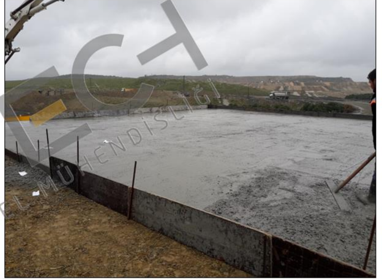
Betonarme yük yayma platformu inşaatı
