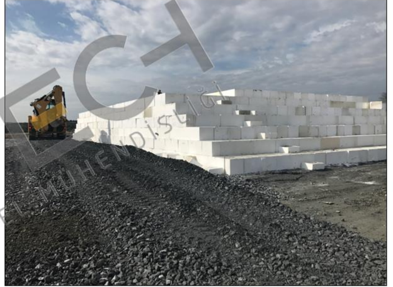
ZEMİN VE TEMEL MÜHENDİSLİĞİ Geofoam blokların yerleşimi
