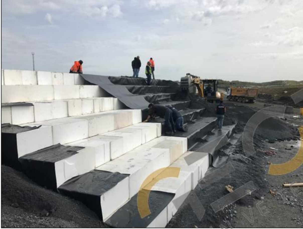
Geofoam blok dolgunun şevli yüzeylerinin PVC geomembran ile kaplanması
