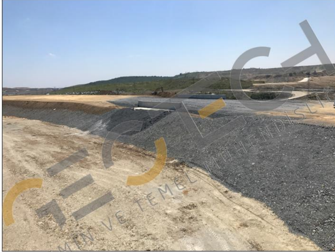
Betonarme yük yayma platformu ve kenar kirişleri (Tamamlanmış imalat)
