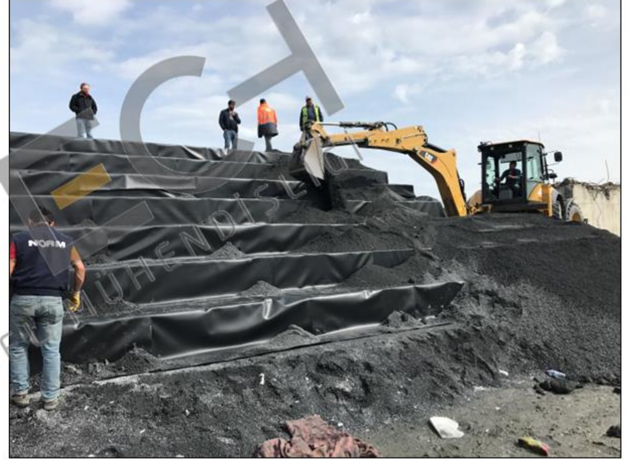
Geofoam blok dolgunun şevli yüzeylerinin PVC geomembran ile kaplanması
