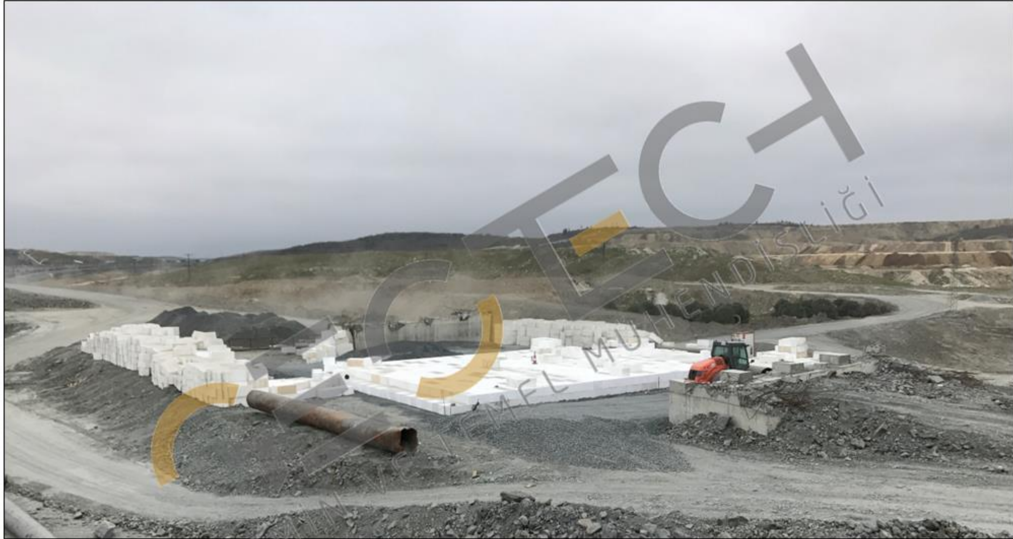
Geofoam blokların yerleşimi
