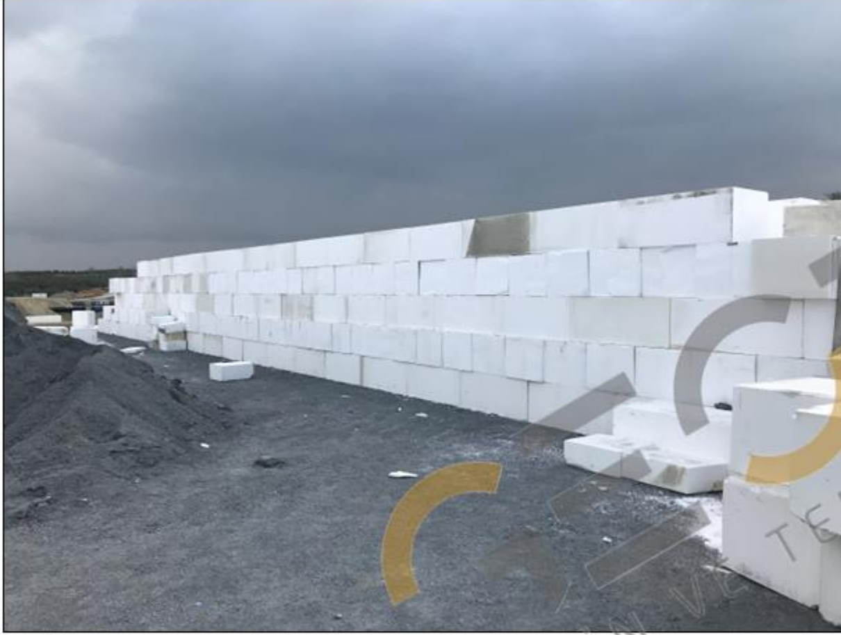
ZEMİN VE TEMEL MÜHENDİSLİĞİ Geofoam blokların yerleşimi
