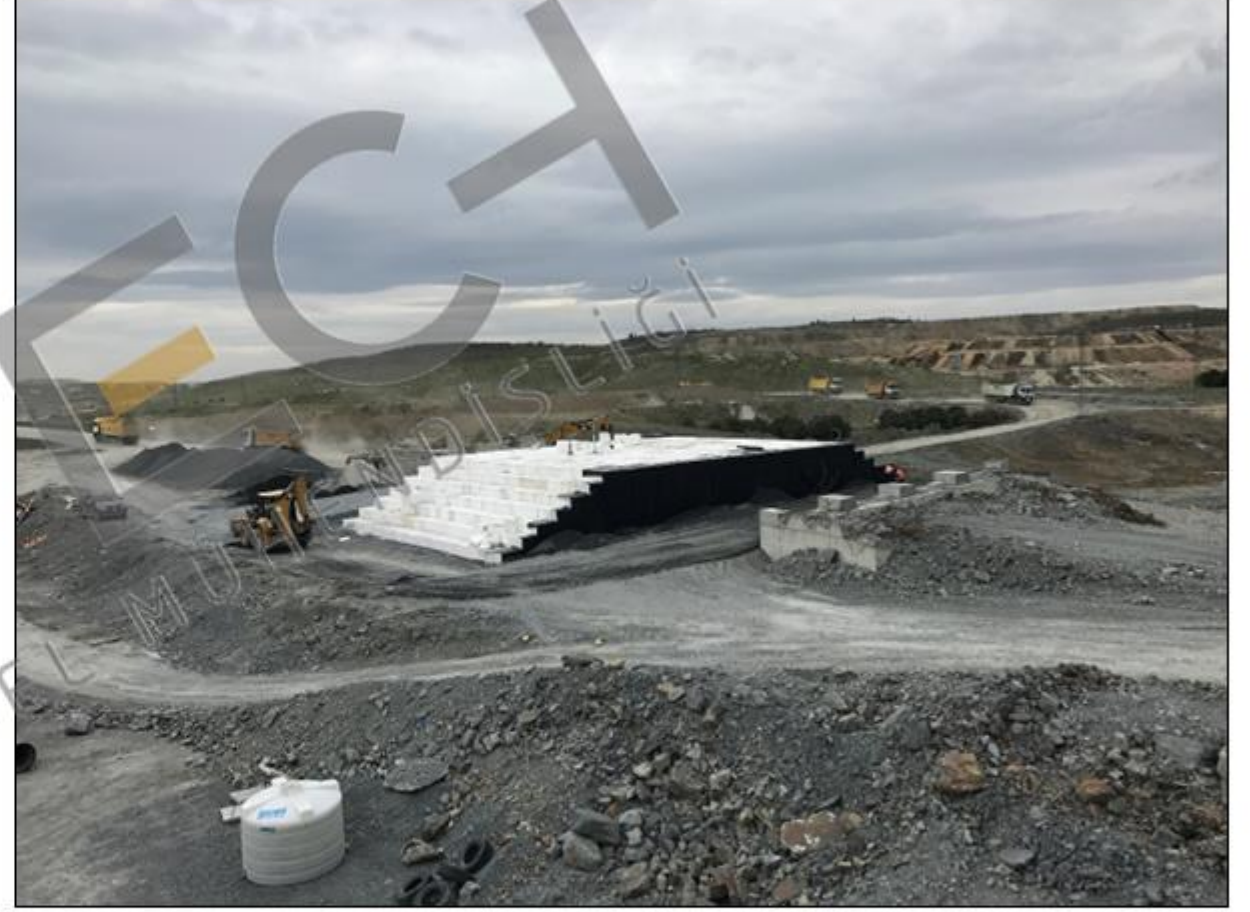
Geofoam blok dolgunun düşey yüzeylerinin PVC geomembran ile kaplanması
