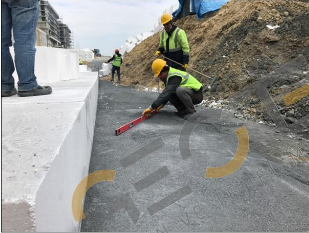
ZEMİN VE TEMEL MÜHENDİSLİĞİ Geofoam blokların yerleşimi
