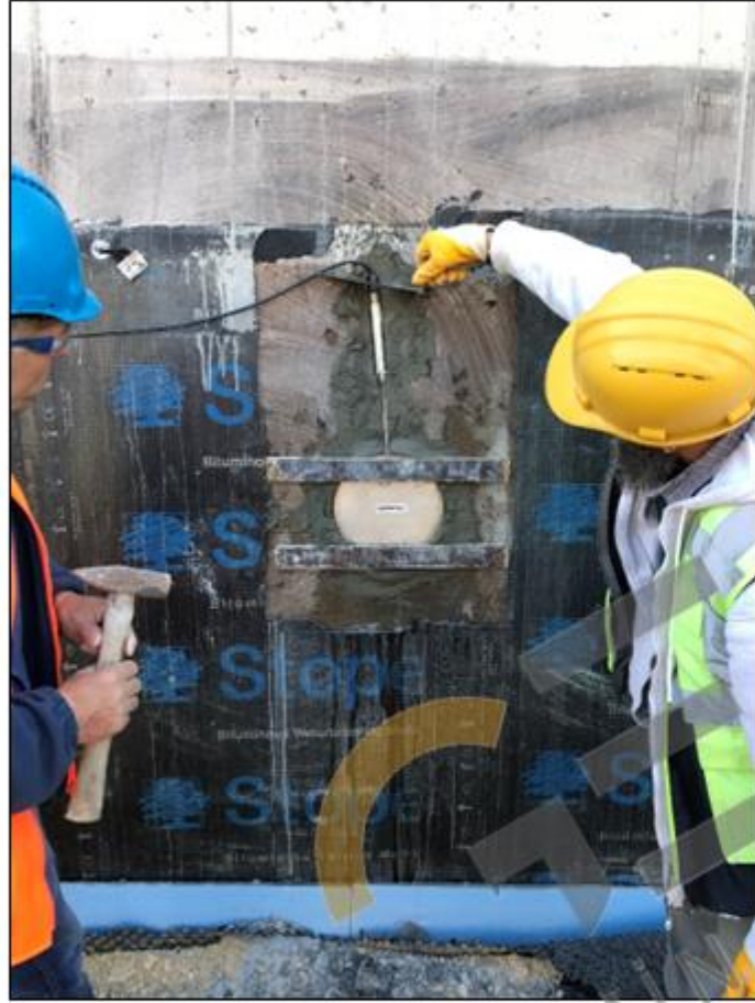
Basınç hücresi enstrümantasyon istasyonu kurulması (Otopark perdesine)
