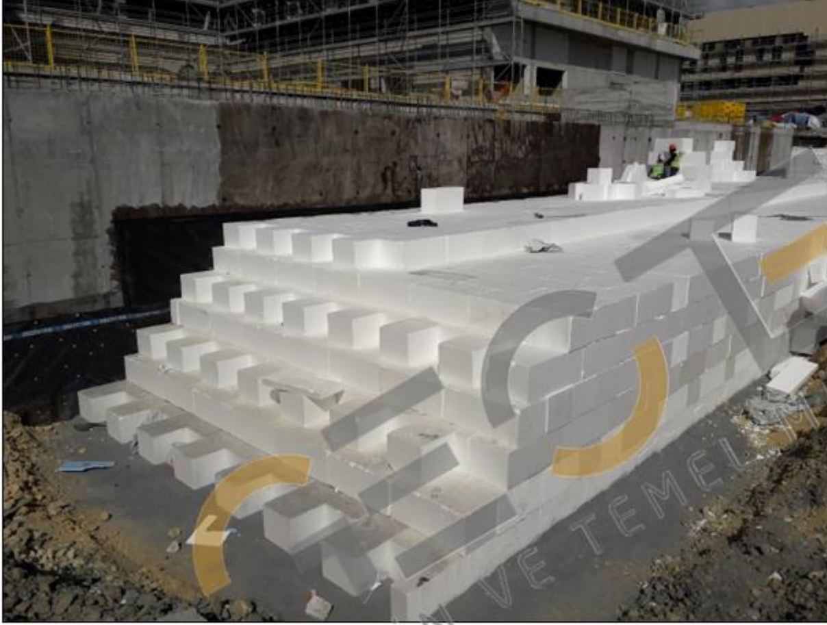
ZEMİN VE TEMEL MÜHENDİSLİĞİ Geofoam blokların yerleşimi
