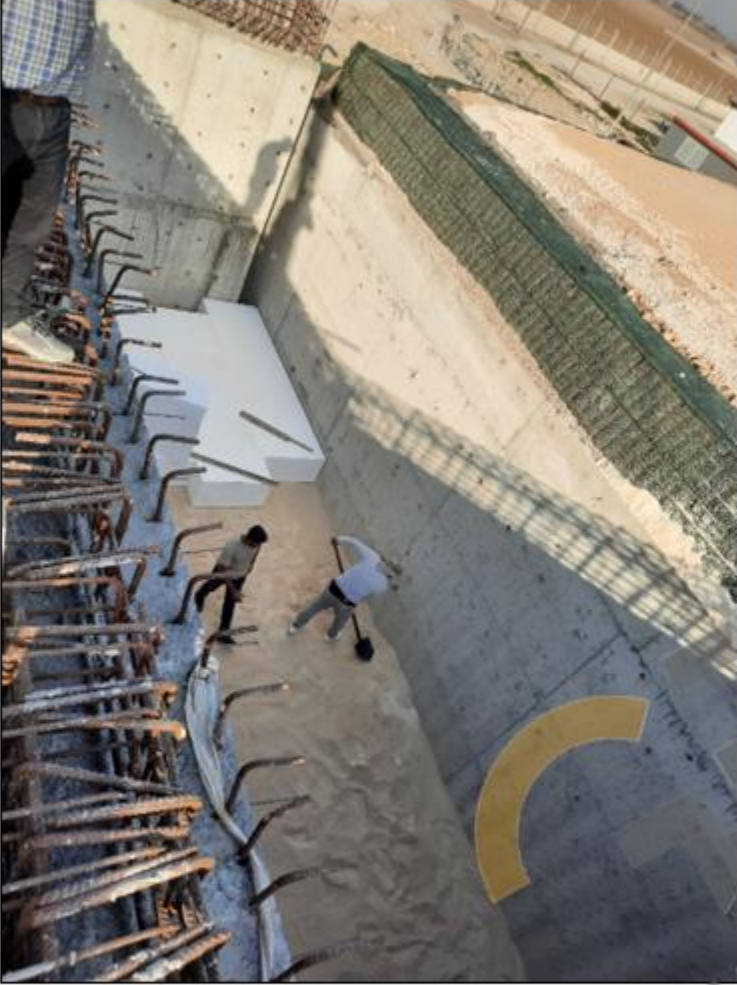
Kum ile temel tesviyesi yapılması
