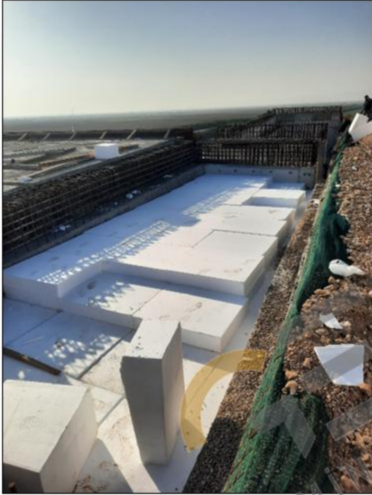
Levha boyutunda geof foam ürünleri ile bitiş kotlarına ulaşılması
