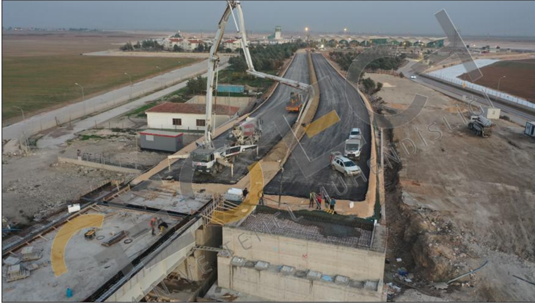
Betonarme yük yayma platformu imalatı
