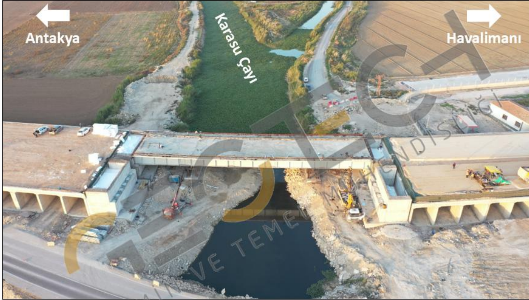
Geofoam blokların yerleşimi
