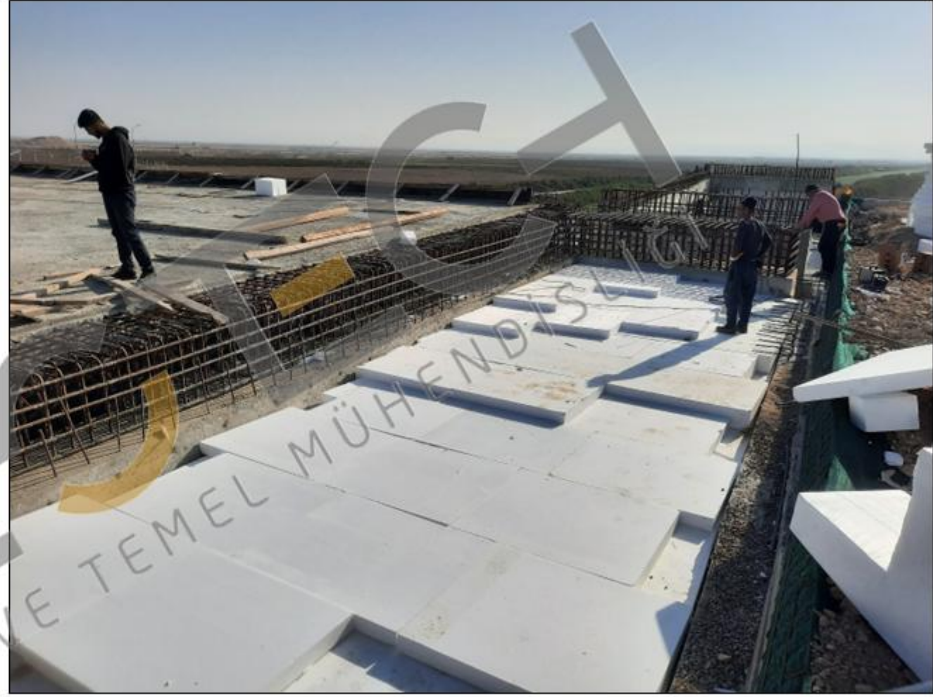
Levha boyutunda geof foam ürünleri ile bitiş kotlarına ulaşılması
