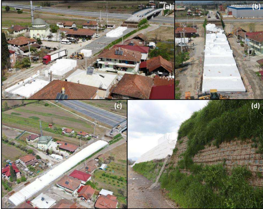
Şekil 11. KMO U48 Köprüsü Geofabric Blok Yerleşimi (a-d) Blokların Yerleşim Planına Göre Sahada Dizilimlerinin Yapılması
