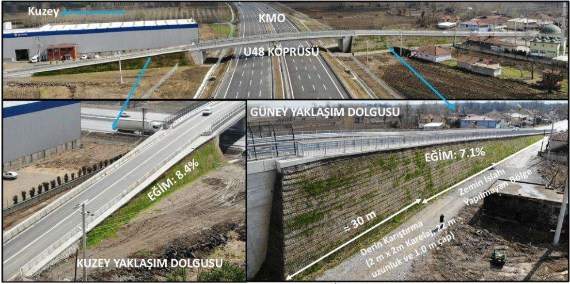
Şekil 8. KMO U48 Köprüsü, İnşaat Sonrası
