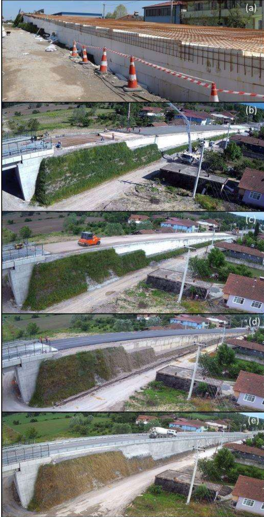
Şekil 12. KMO U48 Köprüsü Esnek Üstyapı İmalatı (a-b) Betonarme Yük Yayma Platformu (c) PMT Serme-Sıkıştırma (d) BSK ve (e) Püskürtme Beton İmalatları
