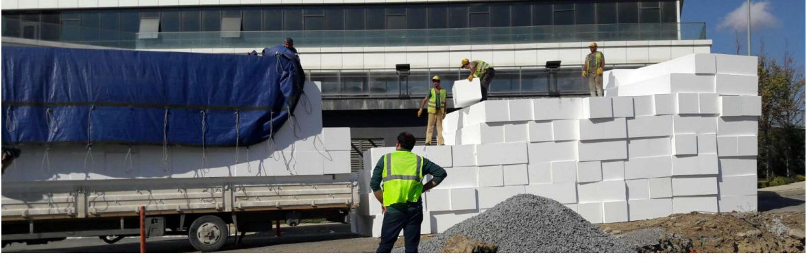
Şekil 1. Geofoam blokların sahaya nakledilmesi ve geçici olarak depolanması, Kayaşehir/İstanbul
