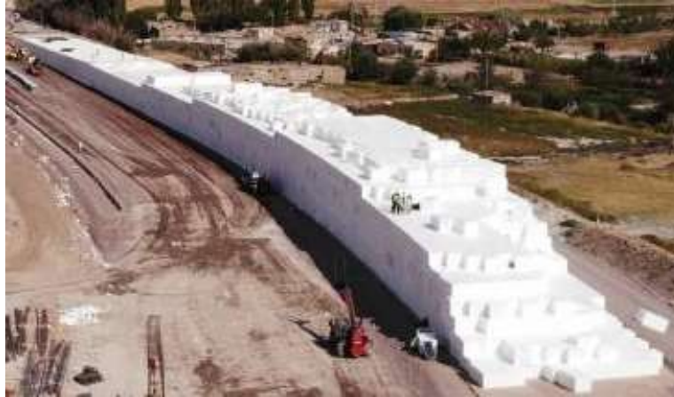
Şekil 7. Kurplu blok yerleşim planının sahada uygulanması, Boğazköprü/Kayseri
