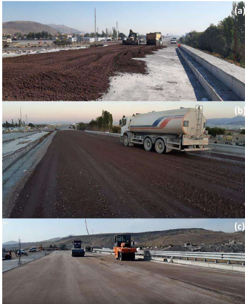
Şekil 10. Yol üst yapısının serme-sıkıştırma yöntemi ile inşası, Boğazköprü, Kayseri (a) PMT serimi (b) PMT sulanması (c) PMT sıkıştırması
