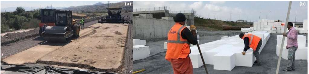
Şekil 2. Tesviye katmanının serilmesi (a) Finişer vasıtası ile serilip, silindir ile sıkıştırılması, Boğazköprü/Kayseri (b) Master vasıtası ile serilmesi, KMO/İstanbul
