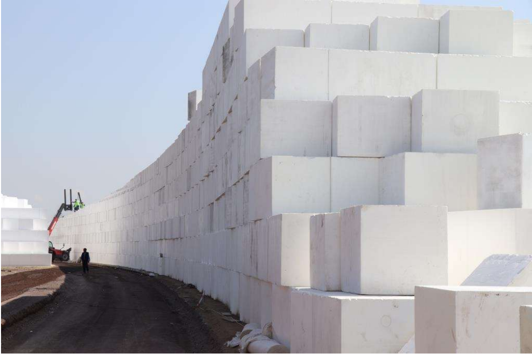
Şekil 6. Kurplu blok yerleşim planının sahada uygulanması, Boğazköprü/Kayseri
