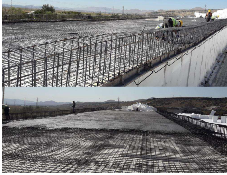
Şekil 9 Betonarme yük yayma platformu inşası, Boğazköprü, Kayseri
