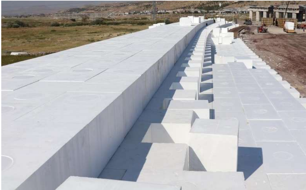
Şekil 4. Geofoam blokların blok yerleşim planına göre yerleştirilmesi, Boğazköprü/Kayseri
