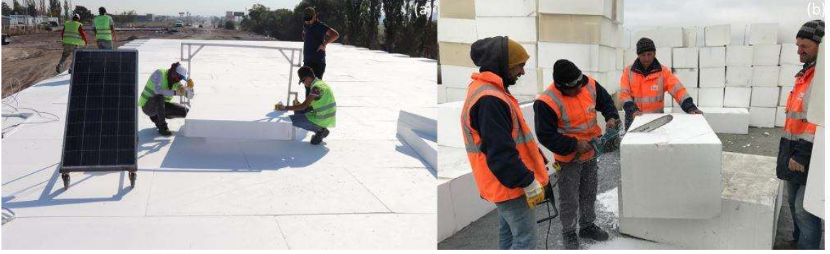
Şekil 5. Blokların sahada özel kesimlerinin yapılması (a) Sıcak tel kullanılarak, Boğazköprü/Kayseri (b) Elektrikli testere kullanılarak, KMO/İstanbul
