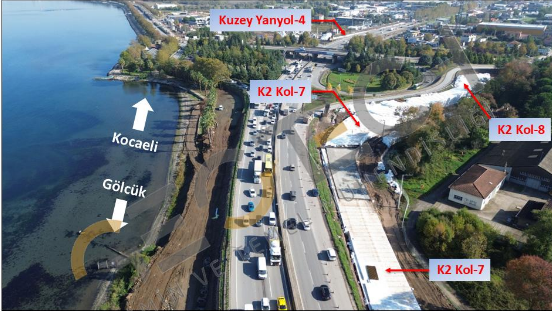
Geofoam blok yanyol dolguları inşaat süreci (20.10.2025)
