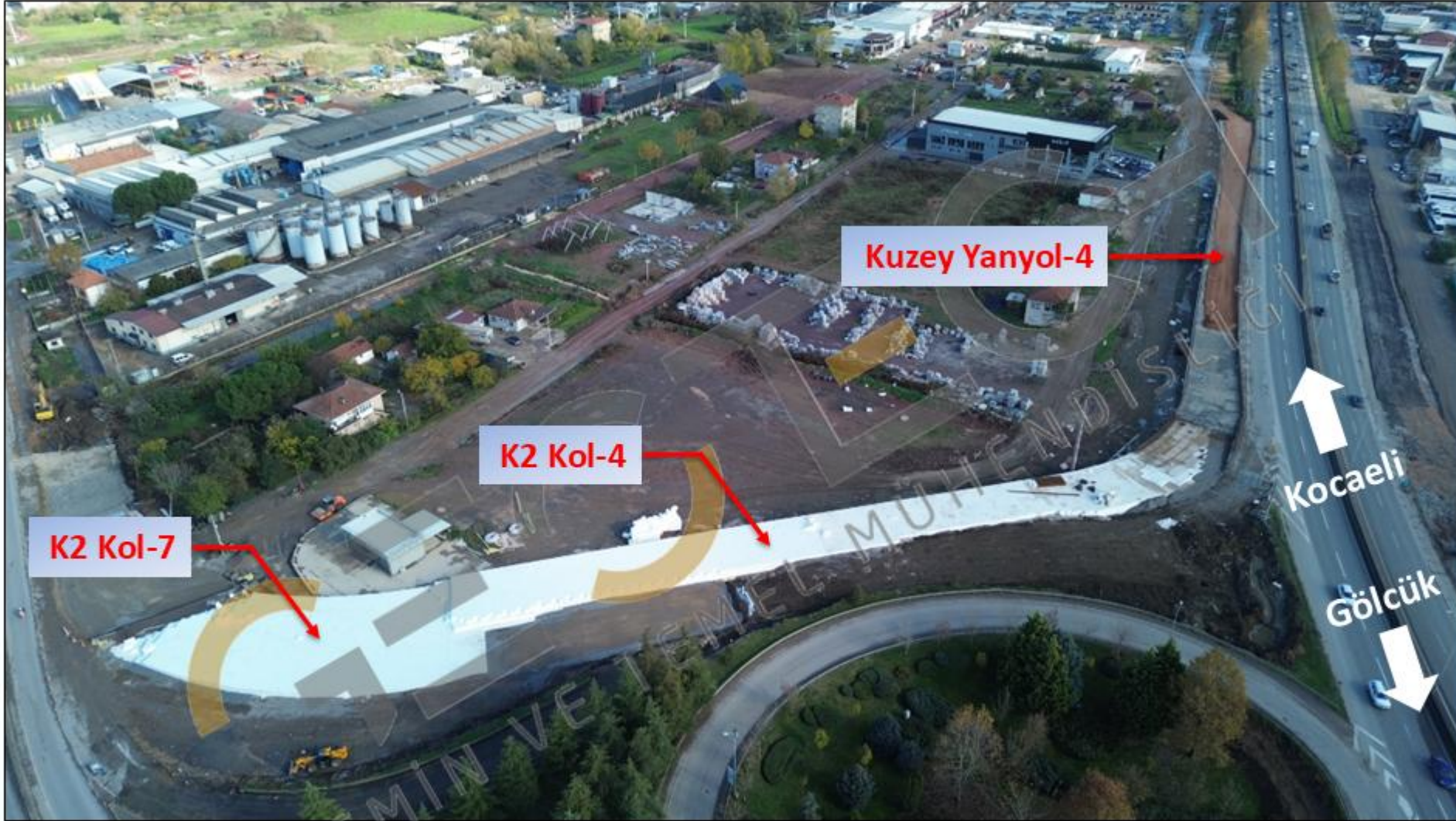
Geofoam blok yanyol dolguları inşaat süreci (24.11.2025)
