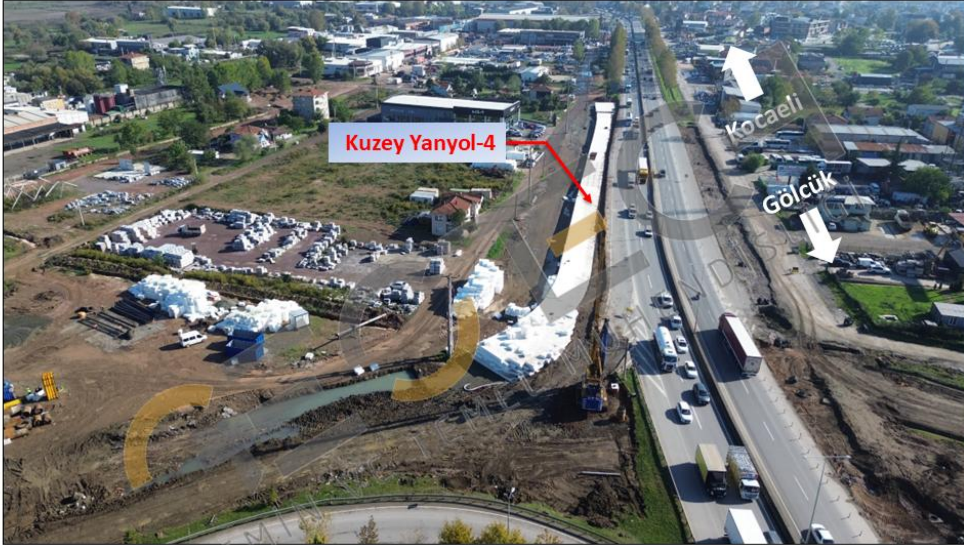
Geofoam blok yanyol dolguları inşaat süreci (20.10.2025)
