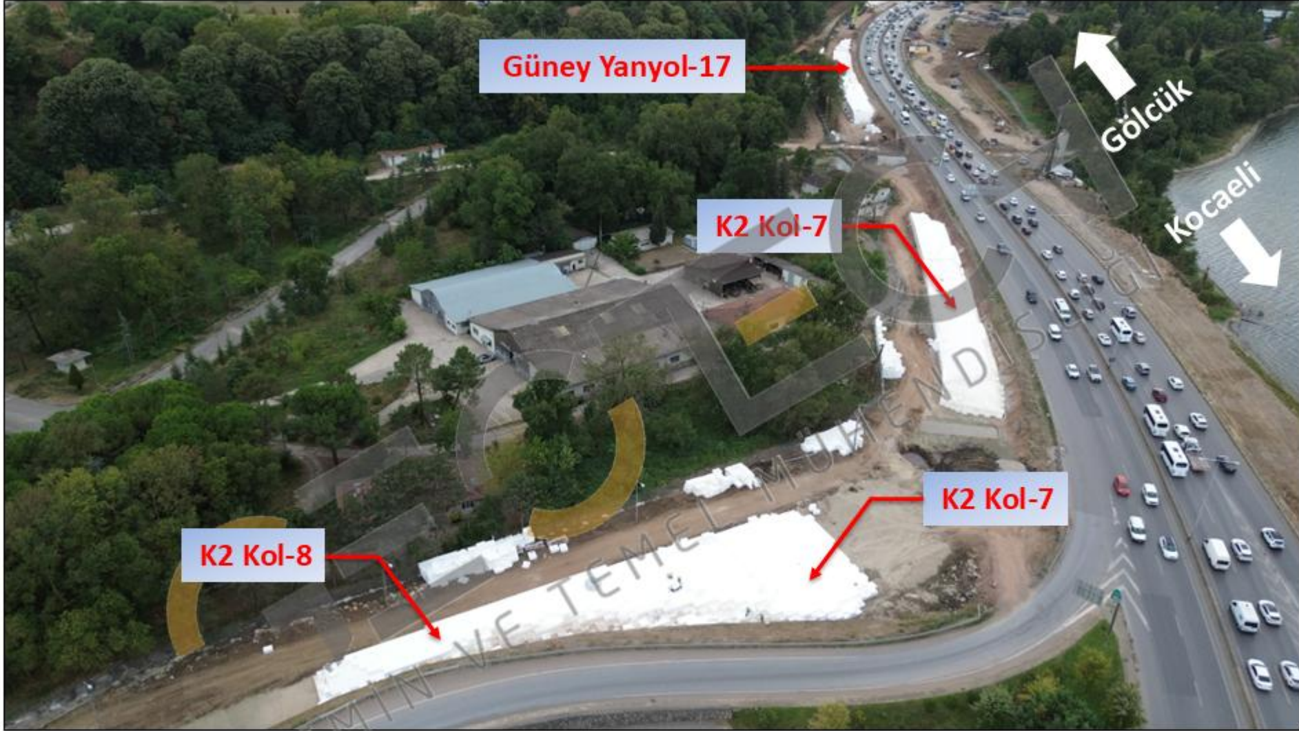
Geofoam blok yanyol dolguları inşaat süreci (17.09.2025)
