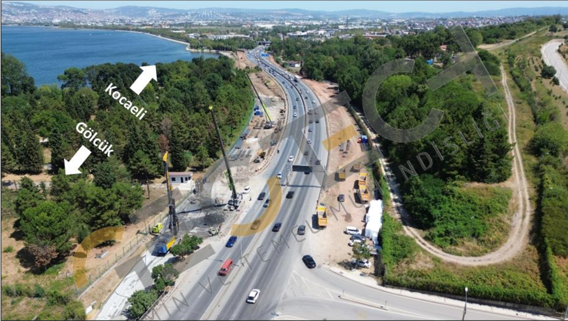
Geofoam blok yanyol dolguları inşaat süreci (15.08.2025)
