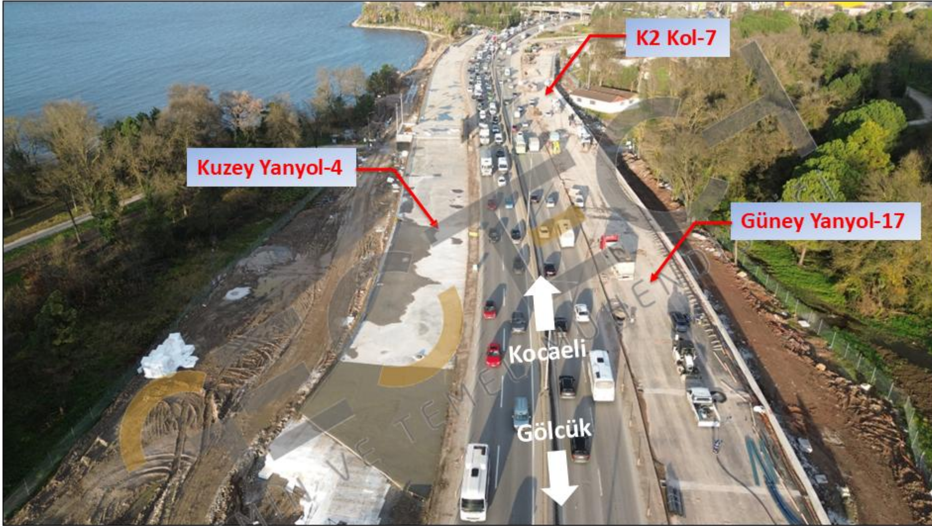
Geofoam blok yanyol dolguları inşaat süreci (29.12.2025)
