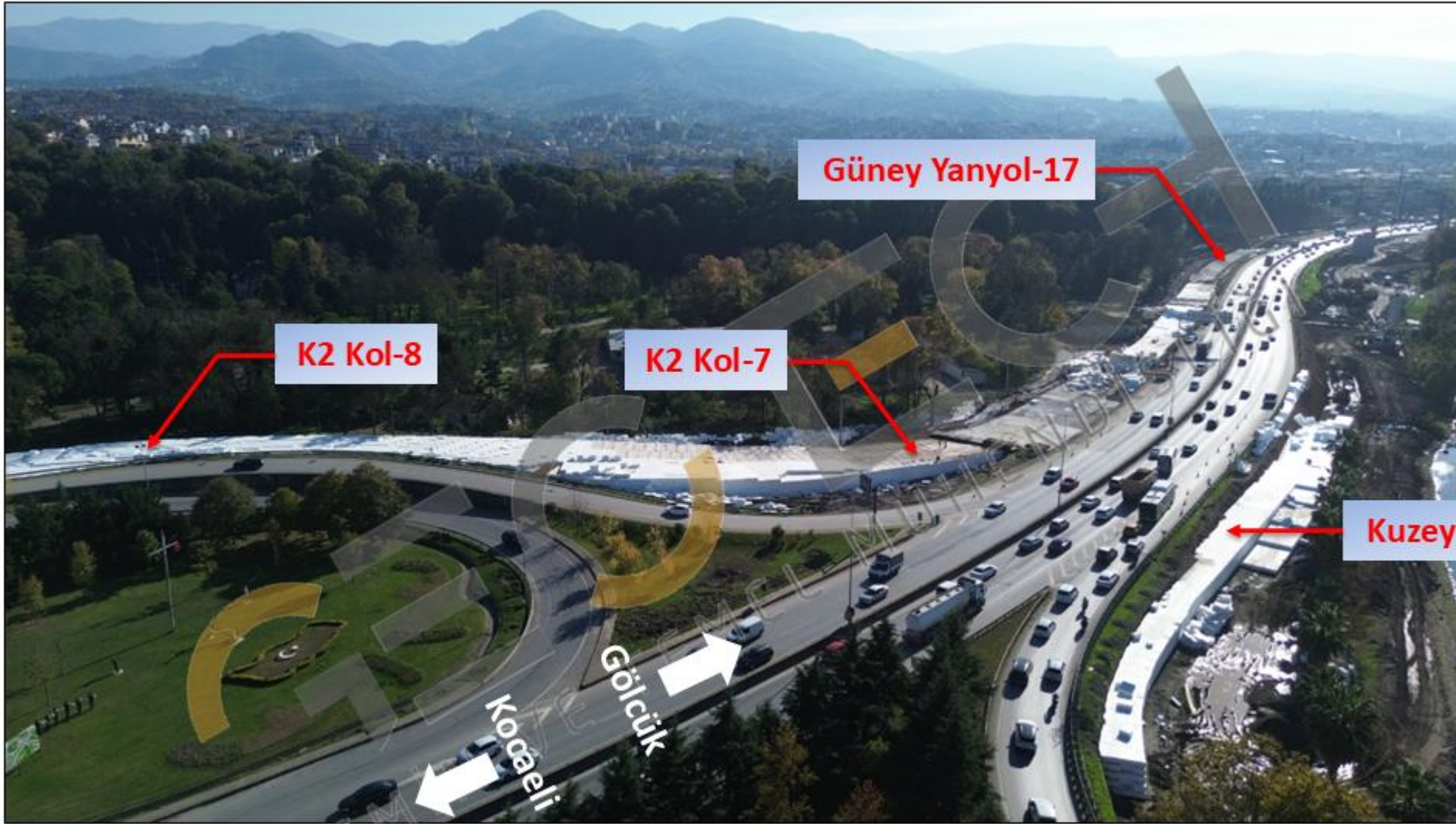
Geofoam blok yanyol dolguları inşaat süreci (01.11.2025)
