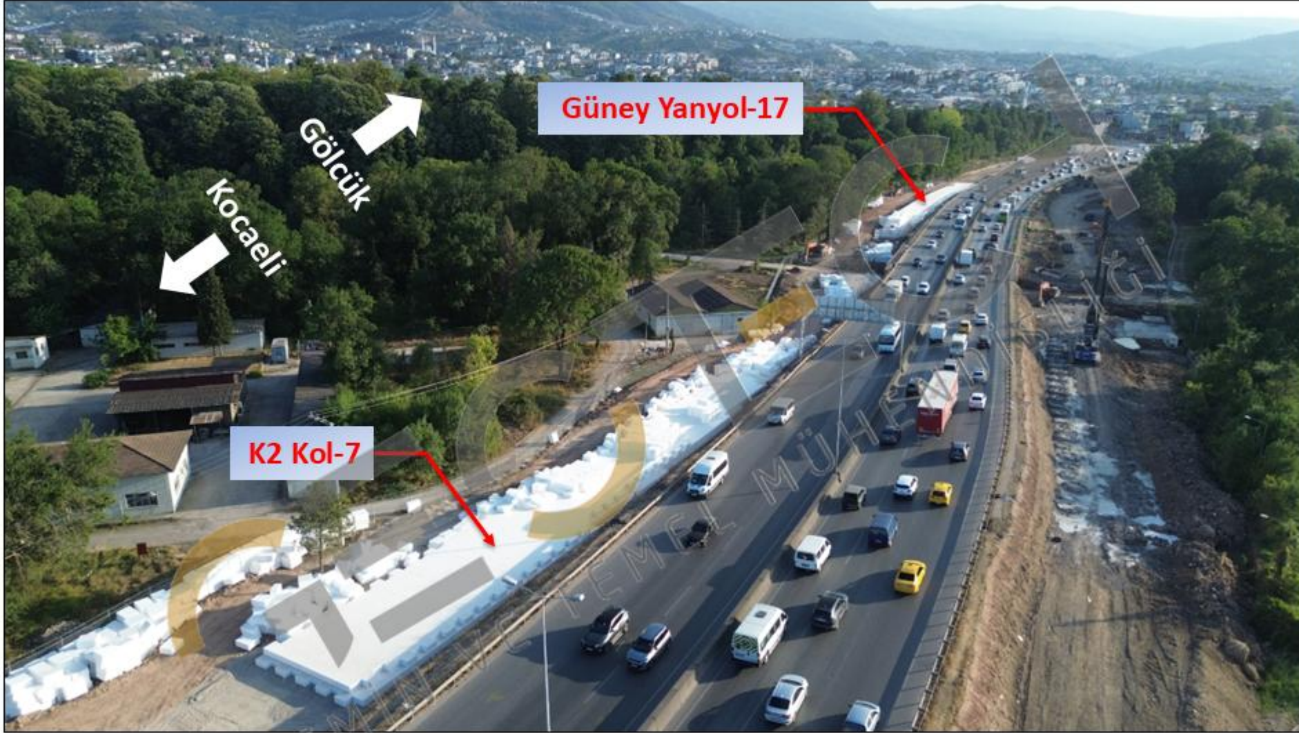
Geofoam blok yanyol dolguları inşaat süreci (05.09.2025)
