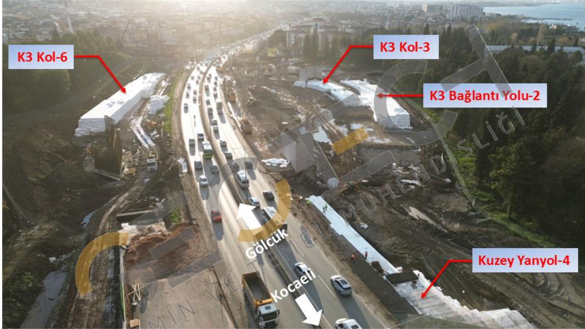
Geofoam blok yanyol dolguları inşaat süreci (29.12.2025)
