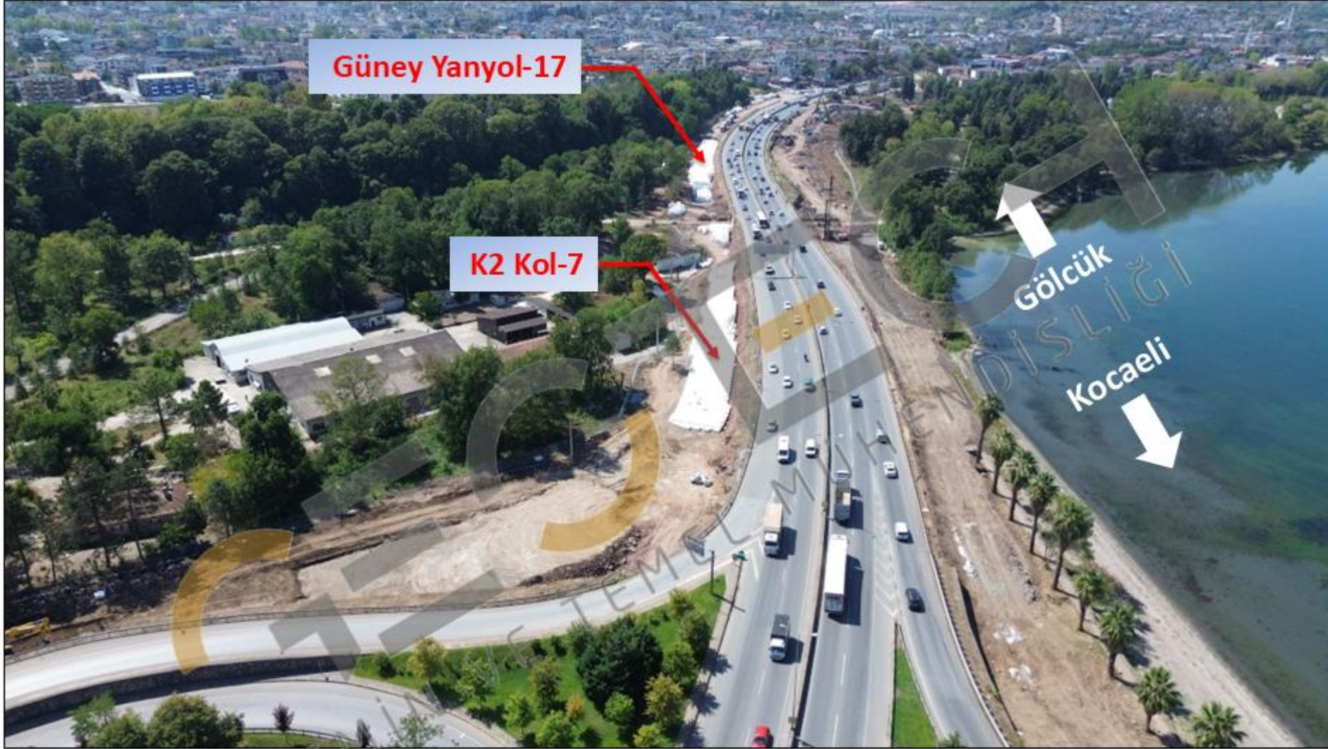
Geofoam blok yanyol dolguları inşaat süreci (11.09.2025)
