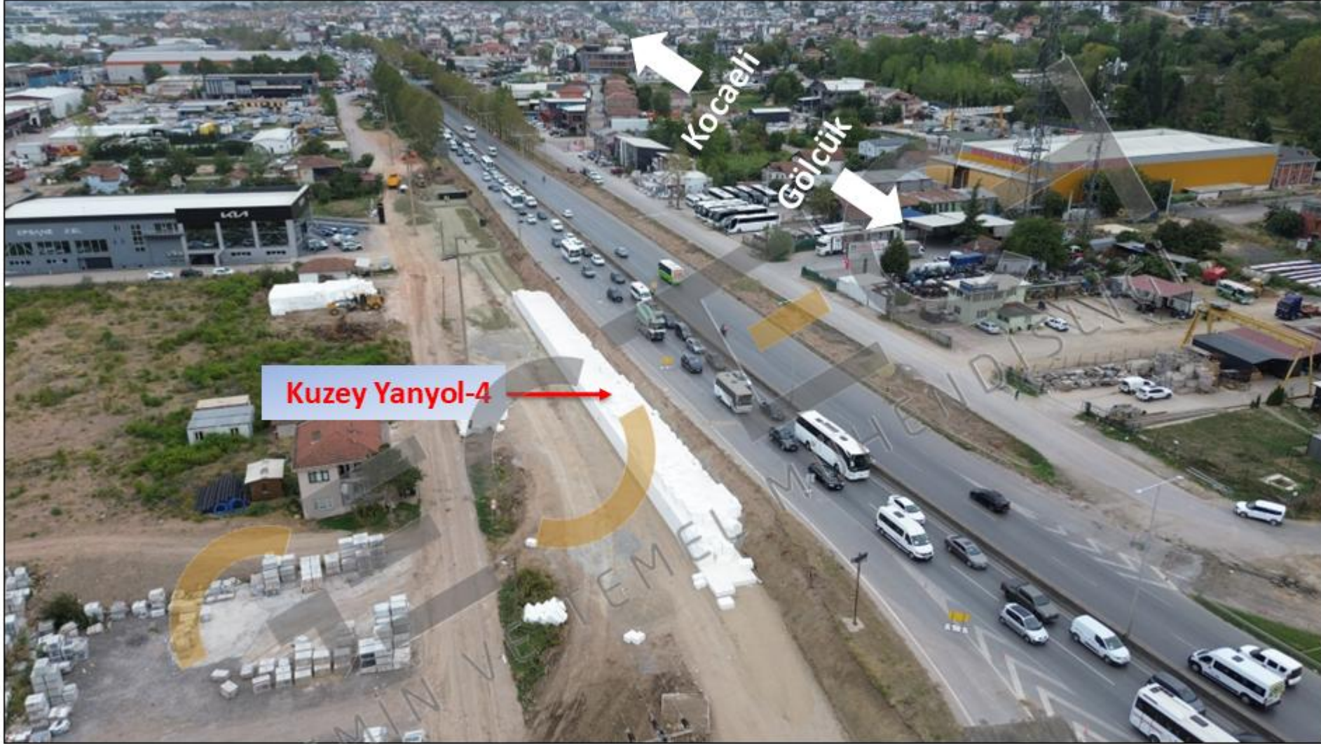
Geofoam blok yanyol dolguları inşaat süreci (17.09.2025)
