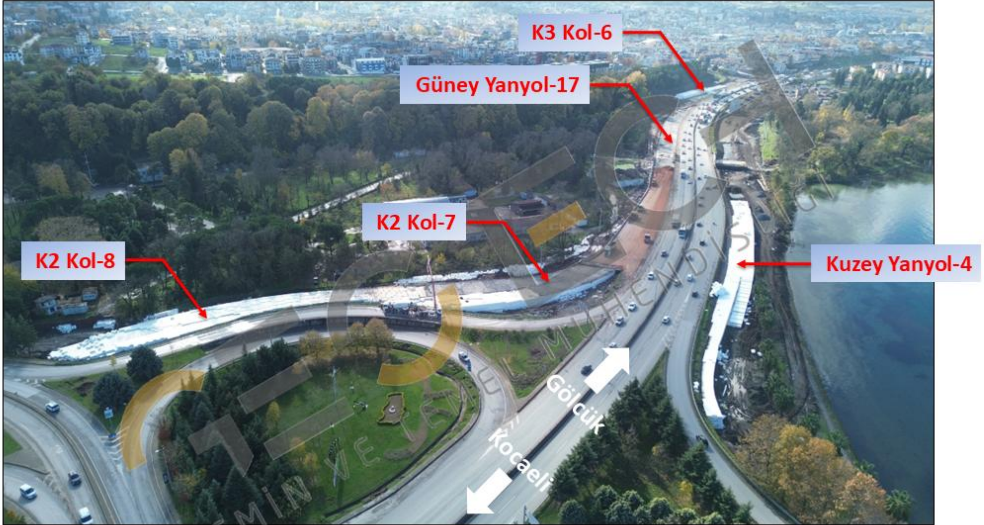
Geofoam blok yanyol dolguları inşaat süreci (24.11.2025)
