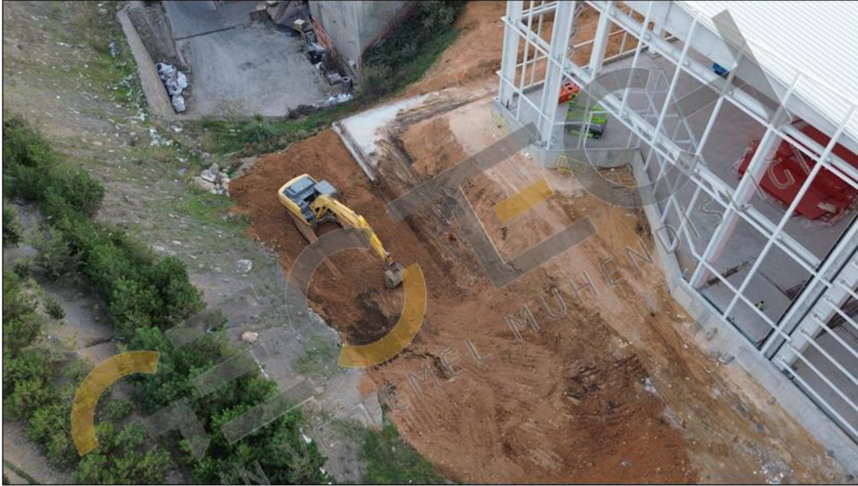
Geofoam blok yerleşimi öncesinde saha hazırlıkları
