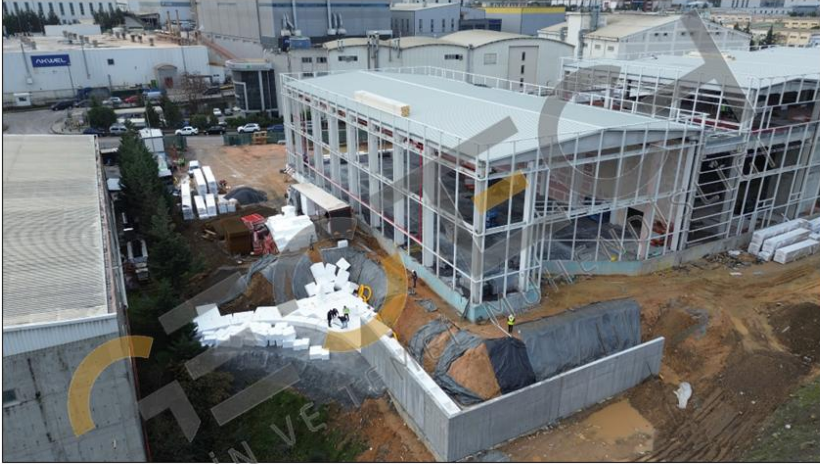
Faz-1 dolgusu için geofom blokları yerleştirilmesi
