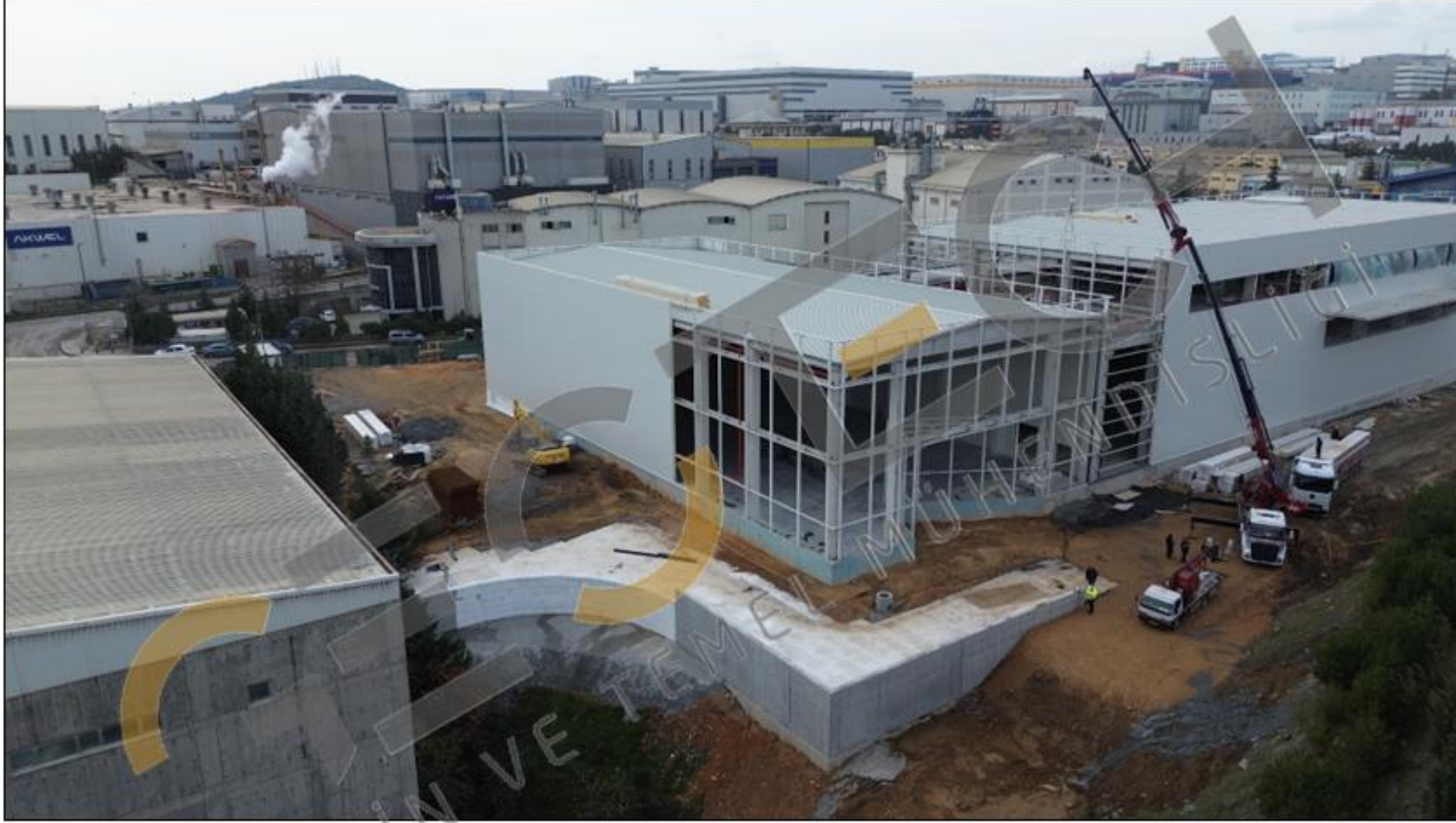
Faz-1 dolgusu için geofom blokları yerleştirilmesi
