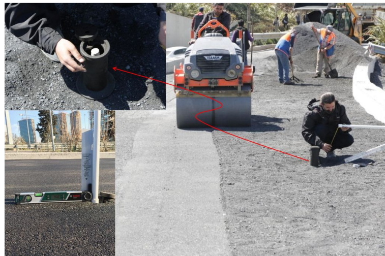
Şekil 9. Dökme Demirden Rögarın Yerleştirilerek Aletsel Gözlem İstasyonunun Tamamlanması
